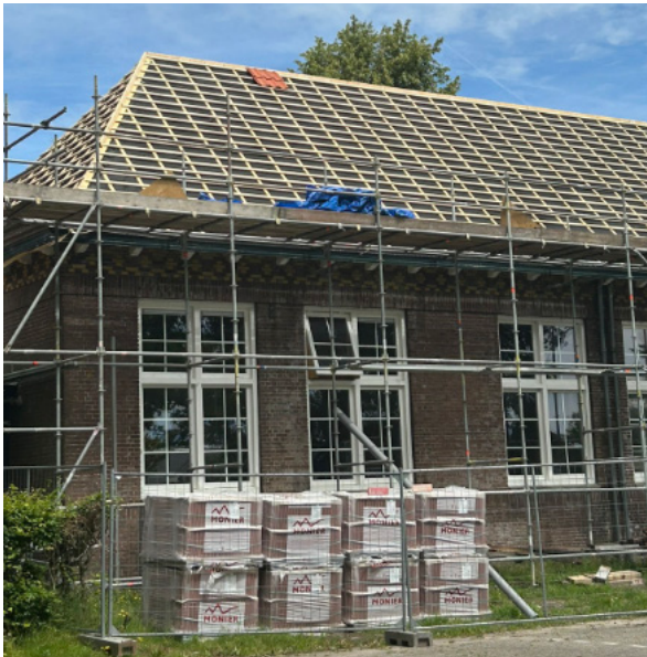
9 juli: de eerste pannen liggen op het dak
